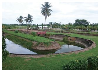
フィジー国の老朽化した下水処理施設
