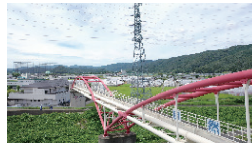
福井県福井市大瀬水管橋をドローンから撮影
